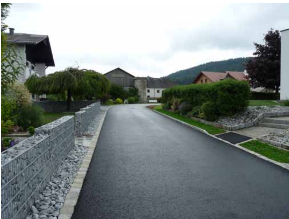
Die Bauarbeiten der Ortsdurchfahrt Zaglau sind größtenteils fertig gestellt
