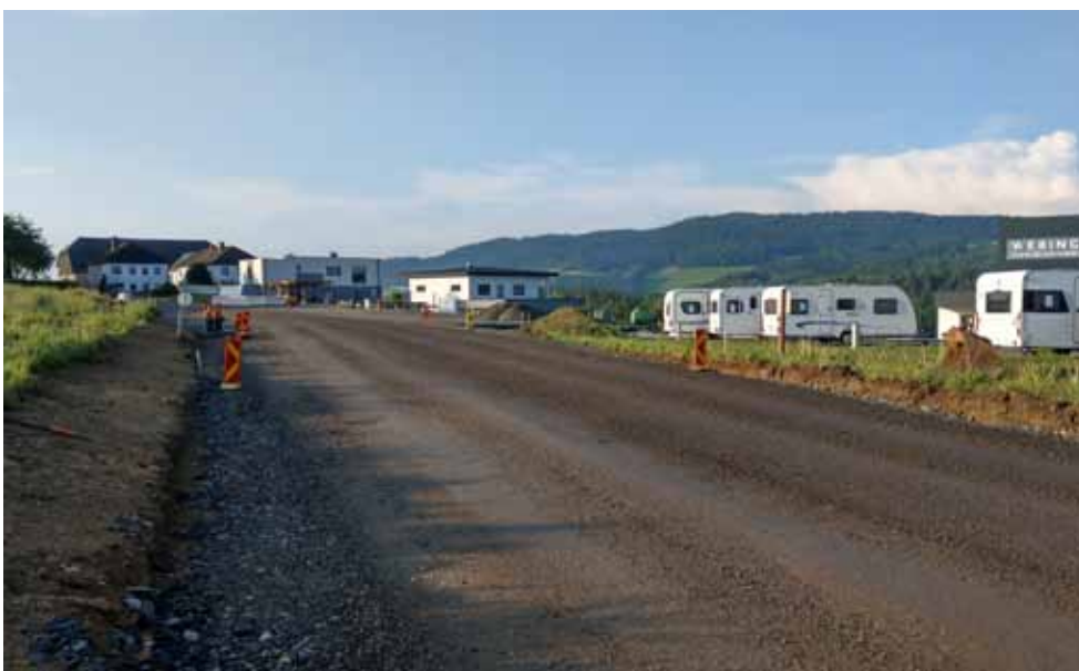
Die Neugestaltung der Landesstraße Stollnberg wird bald abgeschlossen sein
