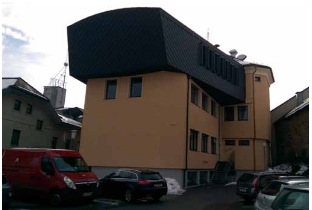
Der neue Musikprobenraum schwebt auf dem alten Bauteil des Rathauses
