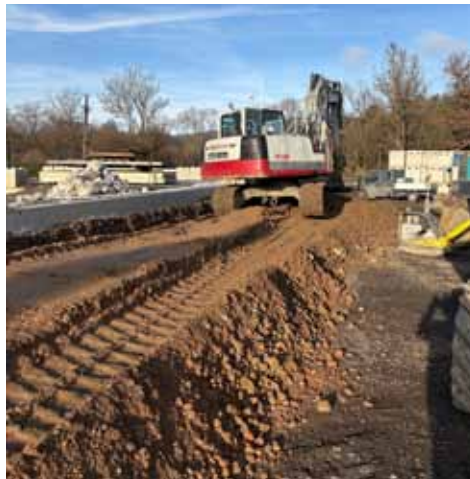
Bauarbeiten für den Anschluss an die Wassergenossenschaft Ulrichsberg.
