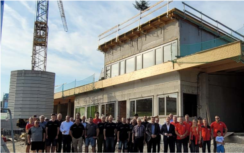
Am 28. September wurde die Dachgleiche beim Einsatzzentrum gefeiert.
